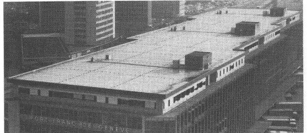
B488 Port-franc, Genève - Architecte: Koechlin René et Mozer Marc, Genève 7'000 m 2 fixés mécaniquement
