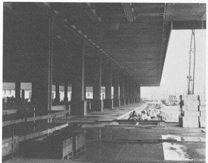
Fig. 6 — Les quais de la gare postale en construction.
