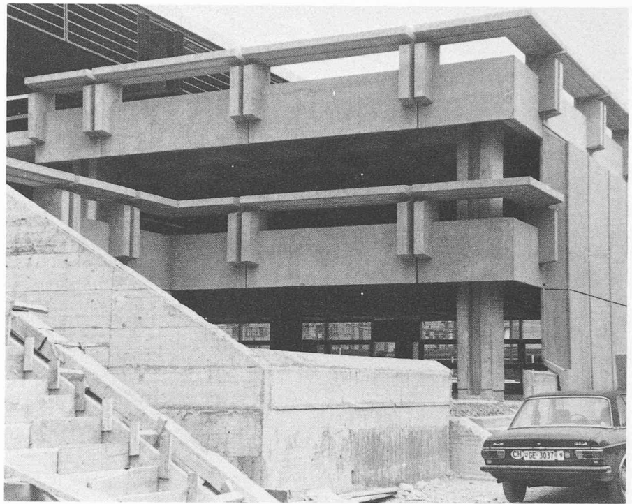
Fig. 4 — Vue partielle de la façade sud, côté rue des Gares.
