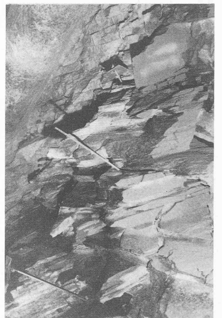
Fig. 3. — Lot d'Oberwald, km 3,775: flambage dans le stross d'une zone de schistes de homblende à fine schistosité.
