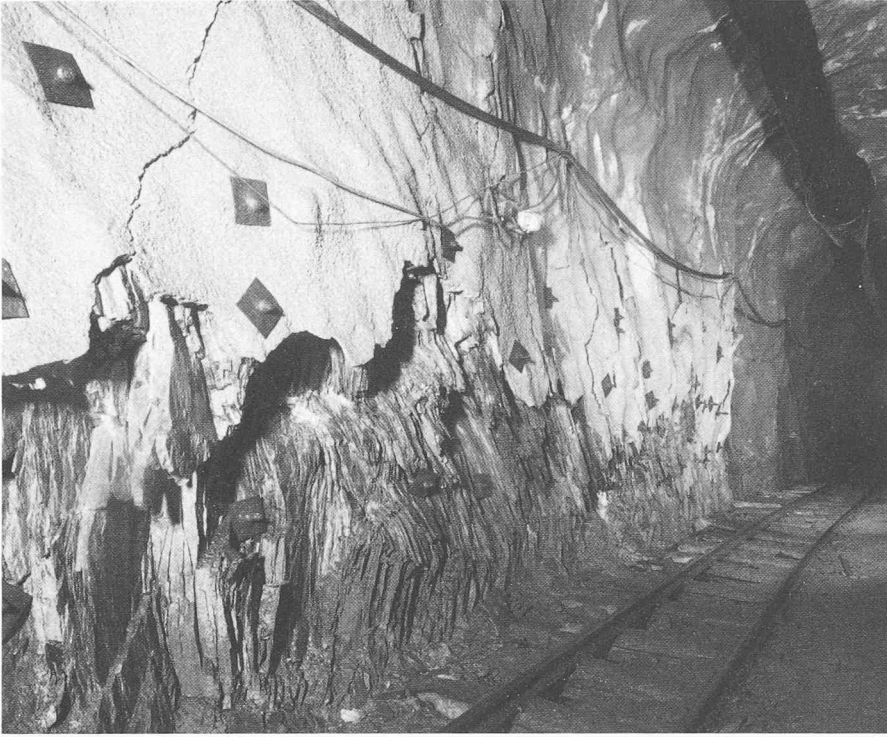
Fig. 4. — km 1,570: état le 23 février 1978, trois ans après l'excavation. On voit la gunite de sécurité nécessaire à l'avancement, les ancrages, le flambage et l'écaillage des paragneiss à fines couches. Couverture: env. 500 m.
