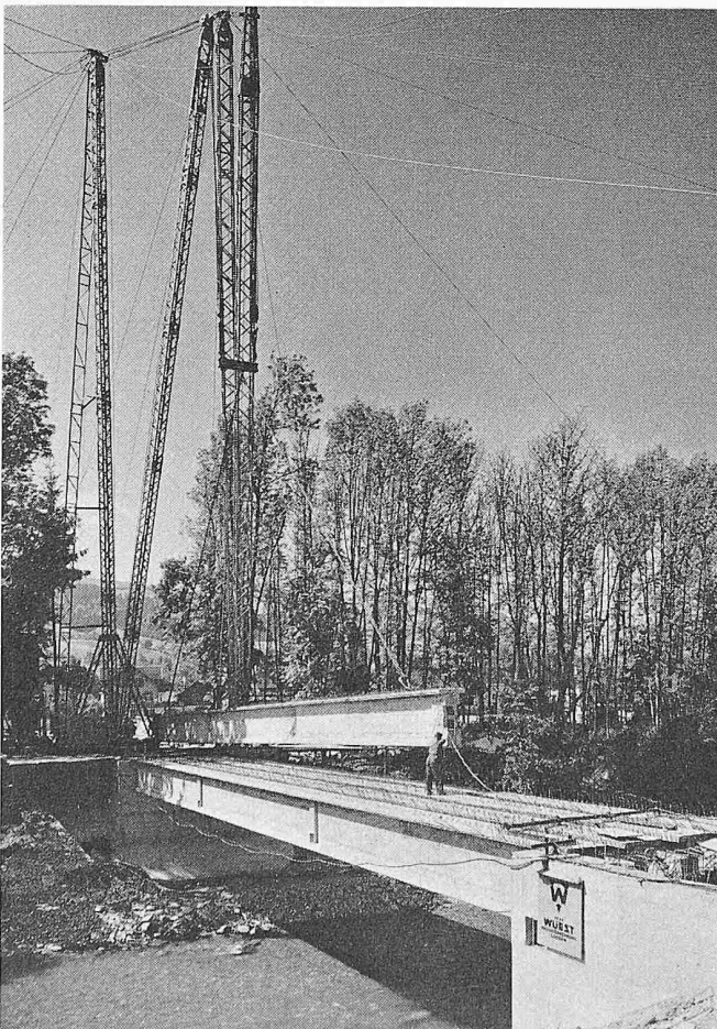
Bild 12. Hellbühlerbrücke über die Kleine Emme in Malters
