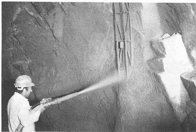
Bild 6. Einspritzen eines Gitterträgers im Versuchsstollen der Hagerbach AG: die Zugabe von Staubbinder unterdrückte die Staubentwicklung und erlaubte, mit  $\frac{1}{8}$  s Belichtungszeit zu fotografieren
