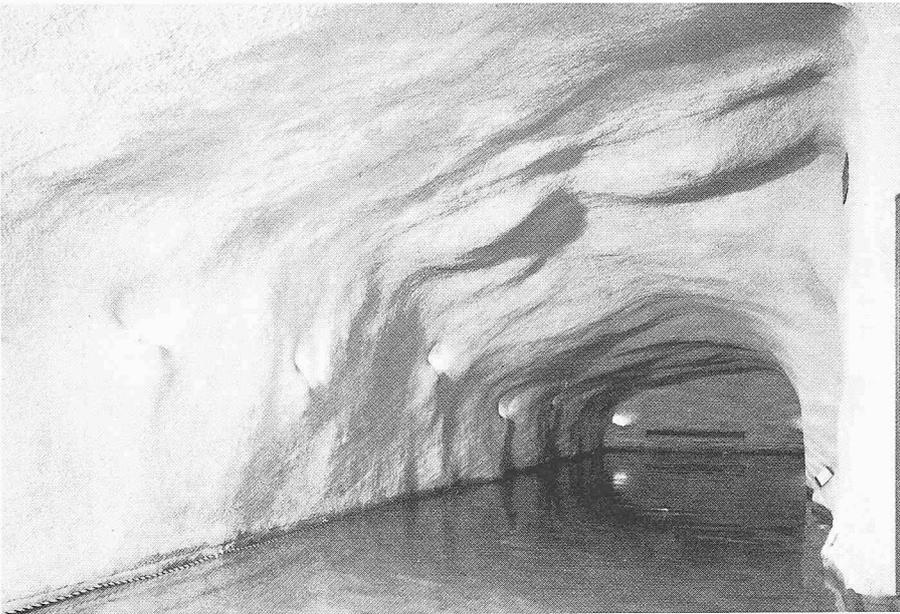
Bild 4. Schwimmhalle in Zermatt – ein gutes Beispiel, dass mit Spritzbeton auch ein anspruchsvoller Innenausbau möglich ist
