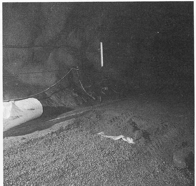
Bild 18. Bahnunterbau. Filterkies und Mitteldrainage. Eingewalztes, zementstabilisiertes Ausbruchsmaterial
