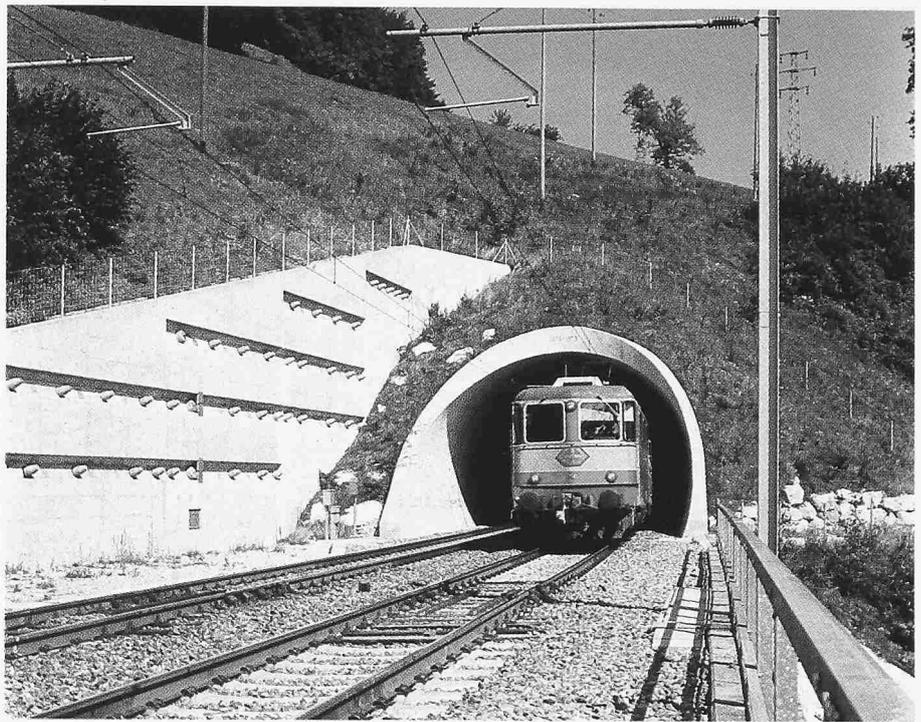
Bild 5. Südportal mit Bohrfahlwand
