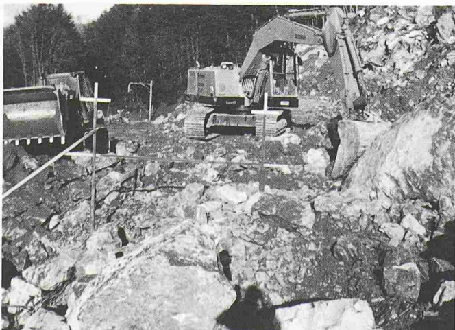
Bild 4. Erstellen des Rohplanums
