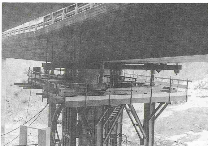
Bild 5. Hebung der Träger
