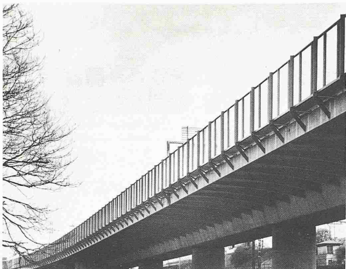
Bild 3. Ansicht der transparenten Schallschutzwand von aussen. Die Hauptträger der Wand sind auf die Unterzüge der Brücke abgestimmt
