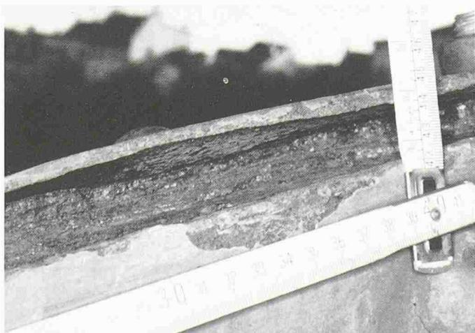
Bild 6. Rostauftriebung einer Gurtlamelle
