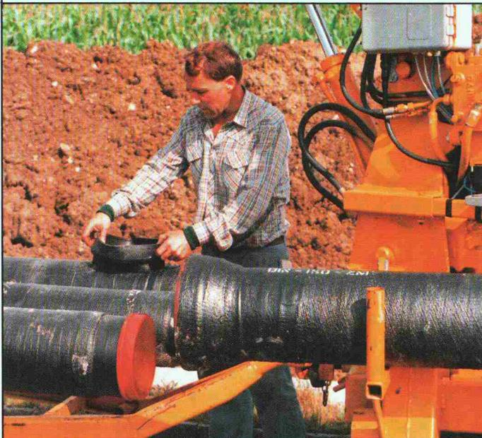
Der Installateur bereitet die Gummimanschette für den Muffenschutz zum Einbau vor. Deutlich ist am Rohr mit der roten Schutzkappe erkennbar, dass das Spitzende auf Einstecktiefe nicht mit dem FZM-Panzer beschichtet wird.
