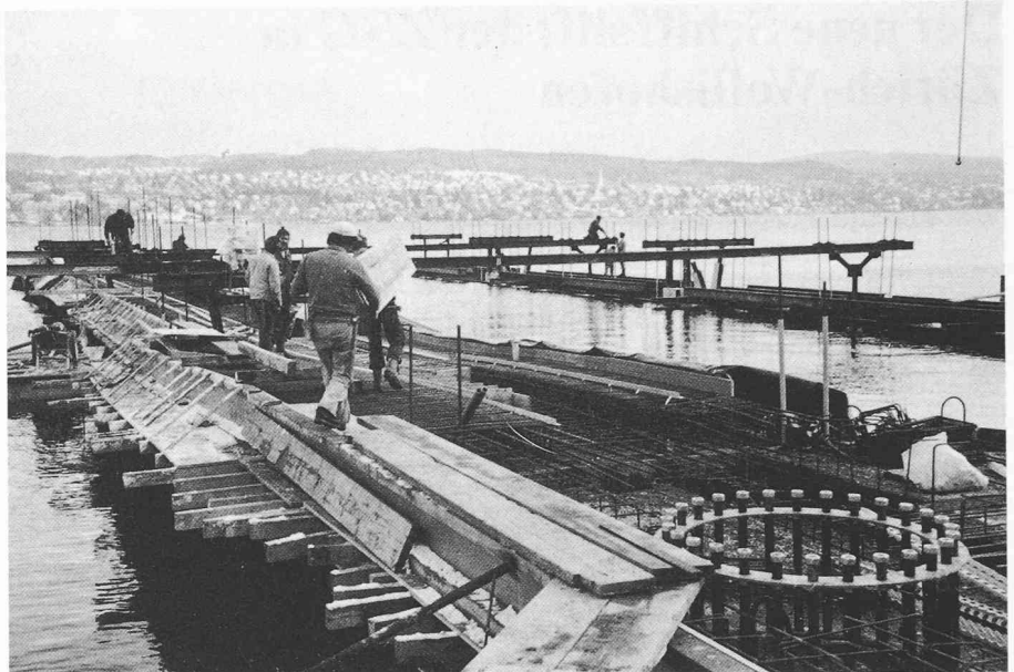
Bild 16. Bau der Schiffsliiftstege
