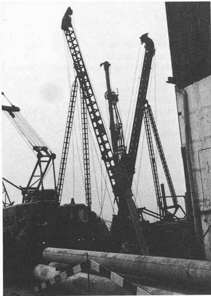
Bild 15. Rammeinrichtungen, die auf engstem Raum arbeiten
