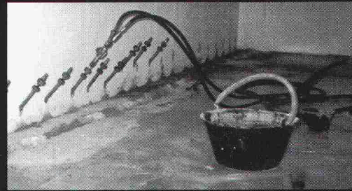
Elastische Abdichtungs-Injektion-Rascorflex in einer Zivilschutzanlage.
