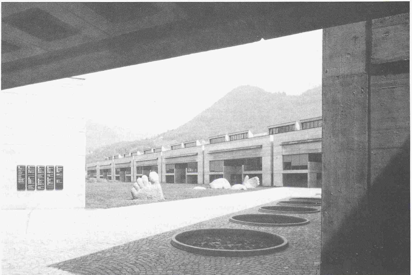
Mario Botta baute die Mittelschule in Morbio Inferiore (Tessin) in den siebziger Jahren am Hang über der Ortschaft. Im weit geöffneten Eingangsbereich ragt die Plastik des Bildhauers Pierino Selmoni aus dem Rasen (Bild: Aldo Zanetta, aus: «Mario Botta», von P. Nicolin, Stuttgart, 1984, DVA)
