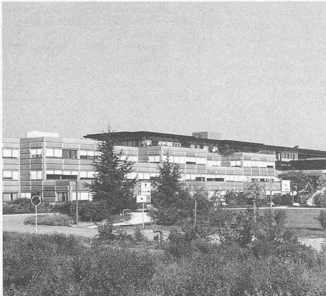
Ecole professionnelle d'horlogerie et de microtechnique EPP/EHMP, Porrentruy; maître d'ouvrage: République et Canton du Jura; architecte: Roméo Sironi SA, Porrentruy
