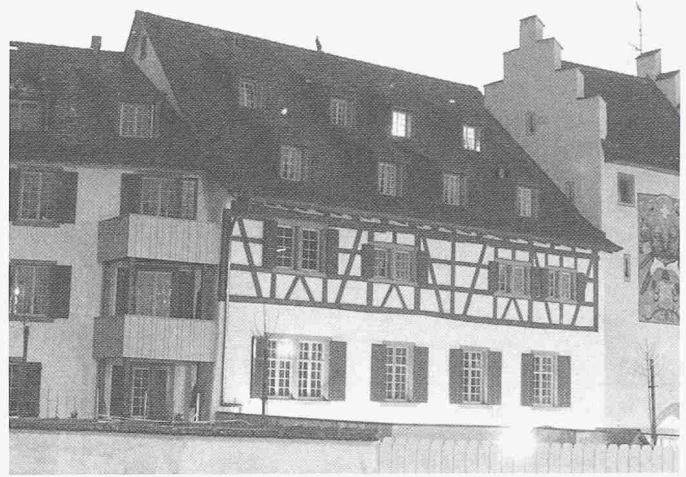
Wohn- und Geschäftshaus Oberhof, Schanz 89, Stein am Rhein SH; Bauherrschaft: Lederfabrik Irmiger AG, Stein am Rhein; Architekten: W. + M. Hui, Weinfelden
