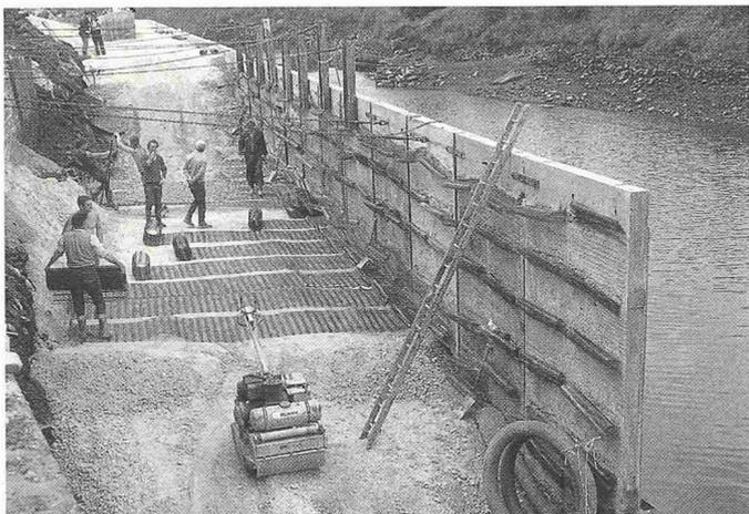
Bauvorgang. Vorfabrizierte Betonelemente mit eingesetzten Geogittern können leicht und zeitsparend eingesetzt werden
