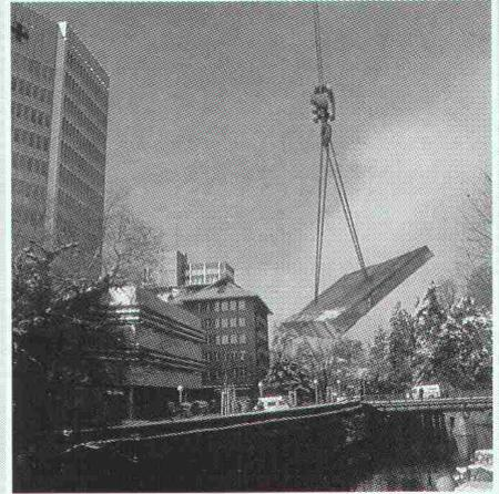
Mehr und mehr gehören solche Szenen zum täglichen Bild der modernen Bauindustrie. Mit Diamantwerkzeugen sauber geschnittene Abbruchteile werden mühelos und ohne belastende Emissionen entfernt.
