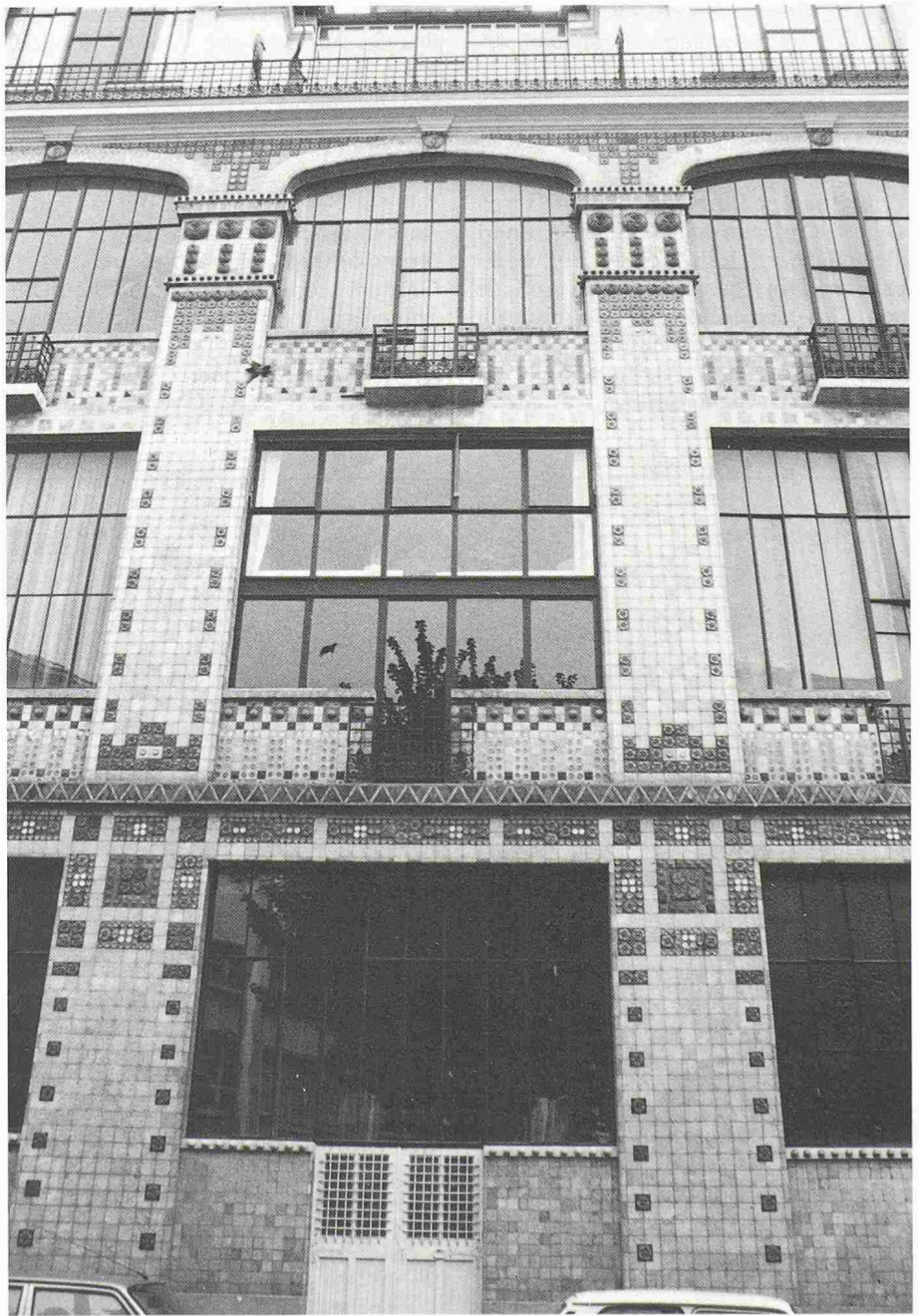
Bild 16. Jugendstil-Fassade eines Atelierhauses, 1901, Avenue Rapp, 7 e , Architekt: J. Lavirotte
