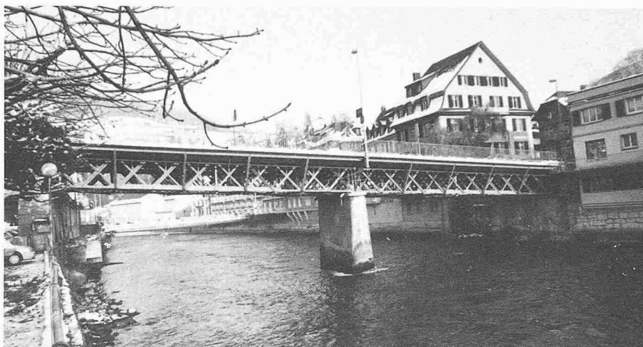
Die schiefe Limmatbrücke Baden, erbaut 1875
