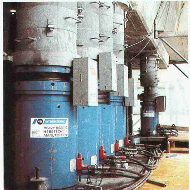
Insgesamt 16 solcher Hydraulikpressen, je 8 mit einer Tragkraft von 350 bzw. 200 t, sind nötig, um den 560 t schweren Brückenteil ausbalanciert zu heben. Im Hintergrund ist einer der bei der Absenkung entstandenen Risse zu erkennen.
