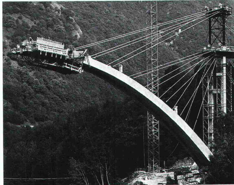
Bau der Ponte Soi-Brücke, Lukmanier-Route.
