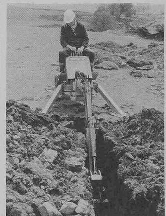
Benzinmotor betätigt den hydraulischen Antrieb.
