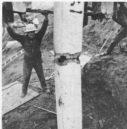
Bild 7. Aufsetzen des oberen Pfahlschusses
