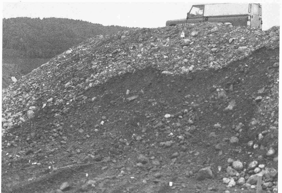
Bild 5. Hang nach der zweiten Hangfussentlastung
