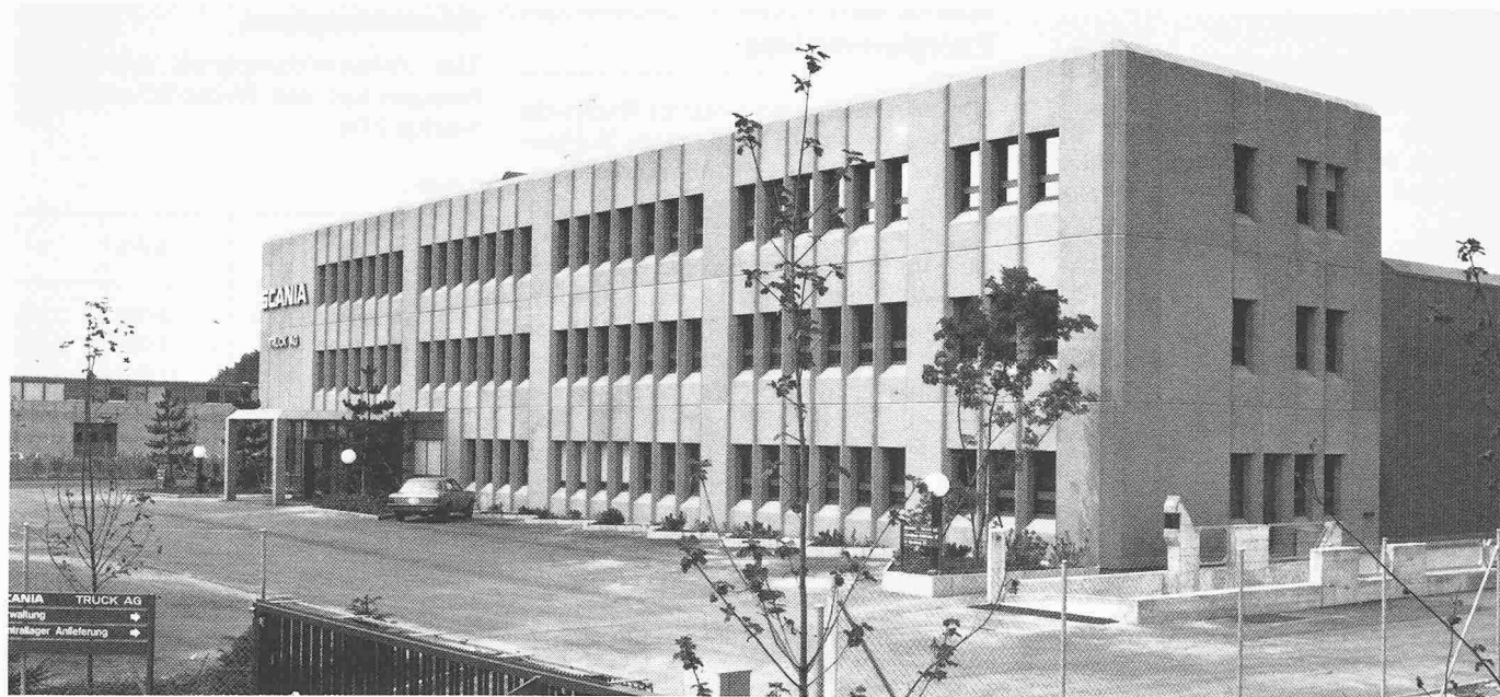
Ansicht des Bürotraktes von Südosten
