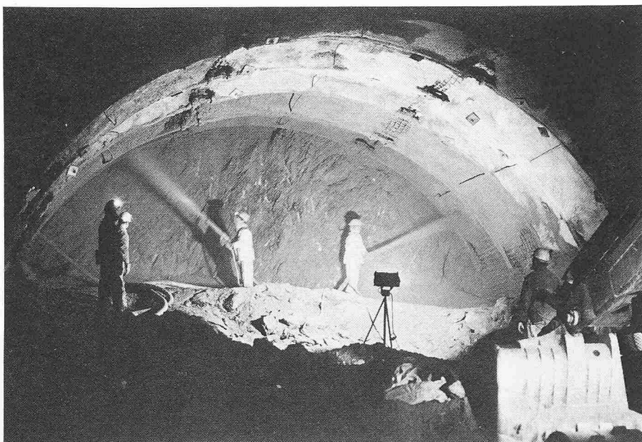
Bild 16. Sichern des Kalottenausbruchs (30 m 2 ) nach der Neuen Österreichischen Tunnelbauweise mit Felsankern, Stahlbögen und bewehrtem Spritzbeton mit Längsschlitz als Bewegungsfugen
