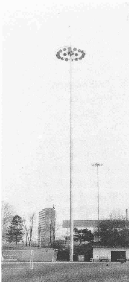
Beispiel eines Schleuderbetonmastes: Beleuchtungsmast (Länge: bis 45 m)
