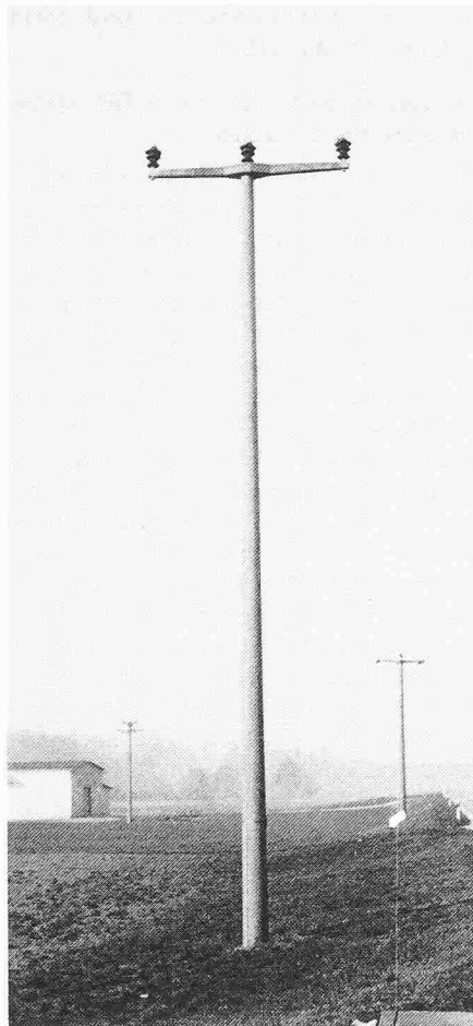
20-kV-Einfachleitung (Tragmast, L = 10-12 m)
