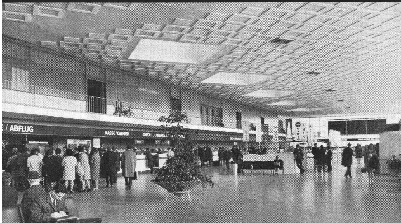
Flughafen Zürich Abflughalle Trakt Nord Bauleitung: Flughafen-Immobilien-Gesellschaft, Zürich
