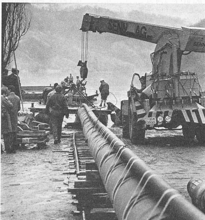
Bild 10. Verlegung des Rheindükers Eglisau. Einschwimmen des Rohres (Photo Comet)
