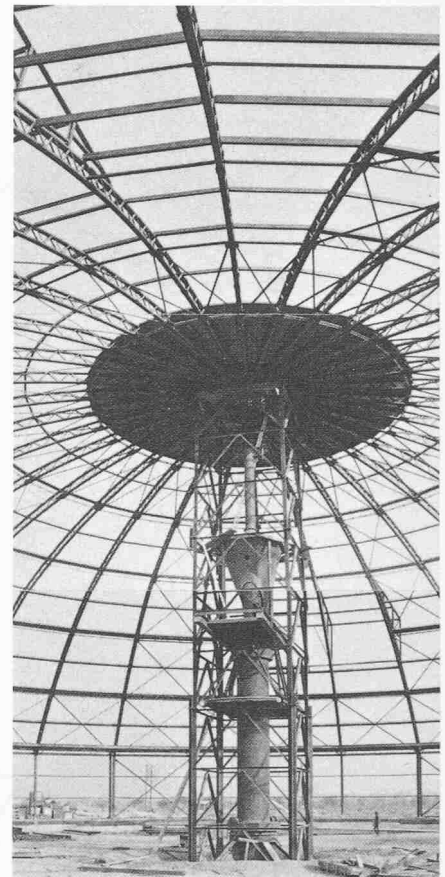
Bild 8. Montage mit Hilfe des Turms
