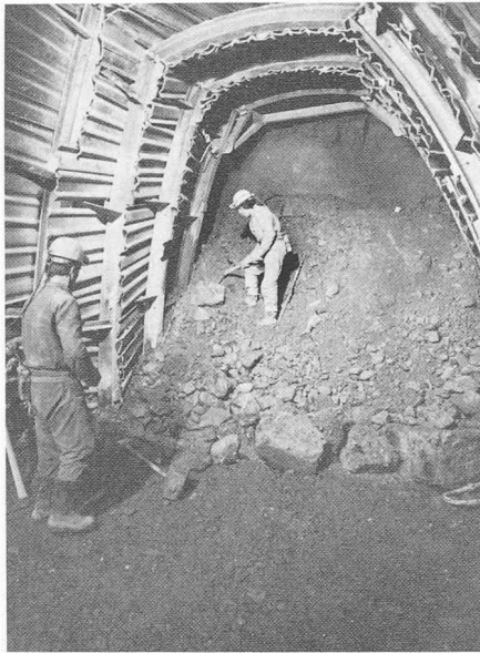
Bild 5. Oberer Paramentstollen Marciavanti-Vortrieb mit Hilfsbogen. Ortsbrust im oberen Bereich mit Spritzbeton gesichert.
