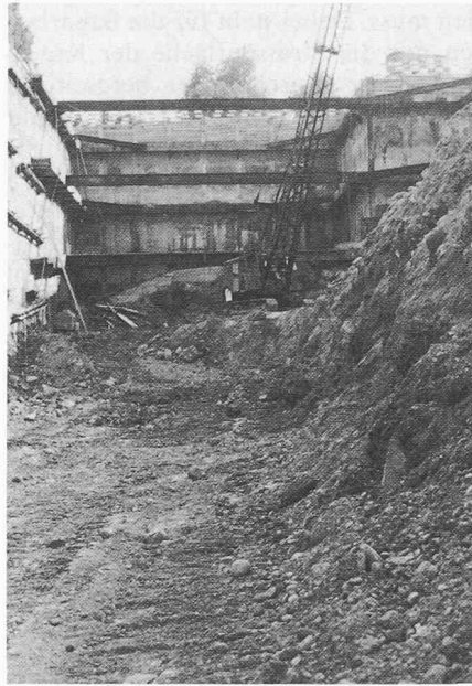
Bild 10. Portalbaugrube Seite Stettbach
