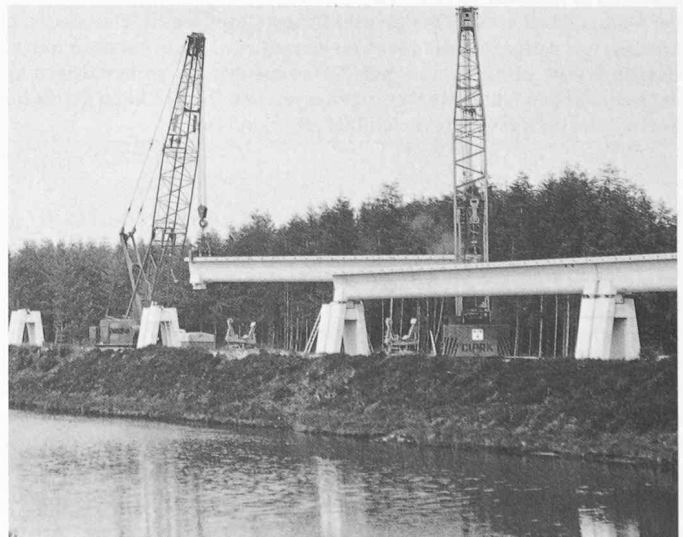
Bild 3. Verlegen der 25 m langen Spannbetonfertigteile für den Betonfahrweg (Bild 2)
