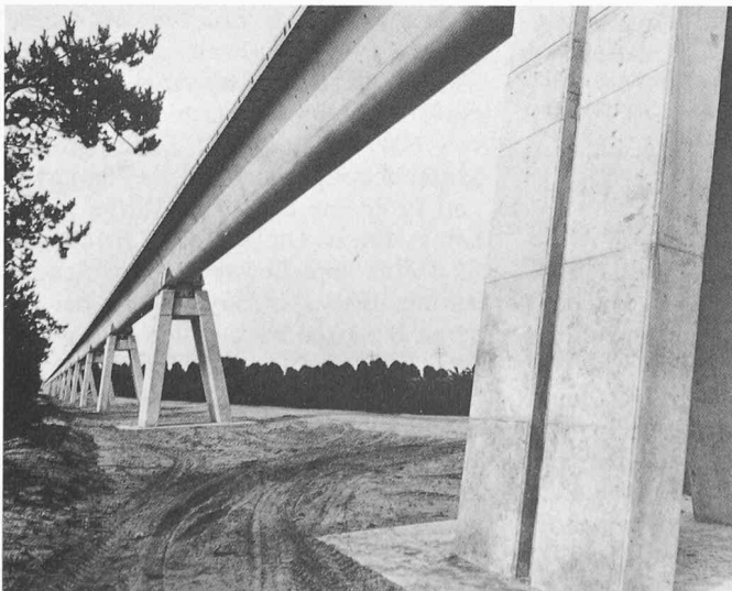
Bild 2. Versuchsstrecke der Transrapid-Versuchsanlage Emsland (TVE) mit aufgeständertem Betonfahrweg für Magnetschwebefahrzeuge
