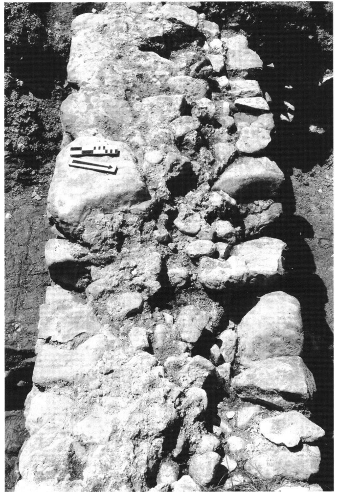
Abb. 9: Letzi Rothenthurm 1999. Schnitt S1. Freigelegte Abbruchkrone der Letzimauer. Die gut vermörtelte, zweihäufig aufgeführte Mauer ist an dieser Stelle ca. 1,1 m breit. Blick von Ostnordosten.
