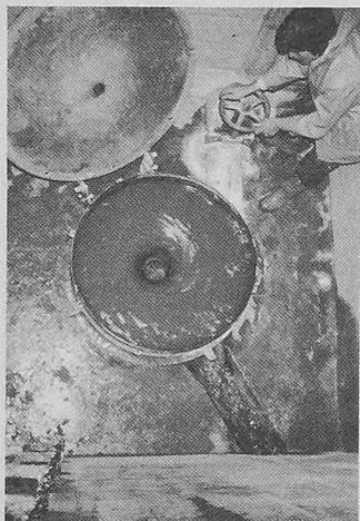
Bild 1. Wirbeldrossel mit geöffnetem Deckel an einem Regenüberlaufbecken
