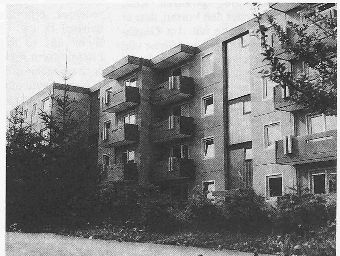
Bild 12. 30-Familien-Haus mit monovalenter Beheizung über ein Massivabsorber-Heizsystem
