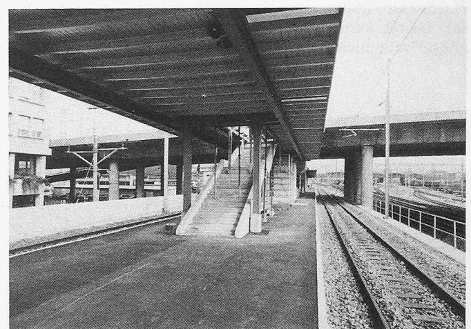
Bild 4. Blick in Richtung Zürich-Hauptbahnhof. Neuer Bahnperon mit dem Treppenaufgang
