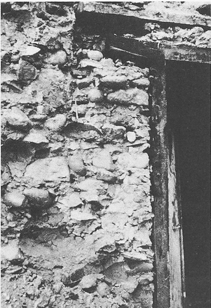
Bild 12. Typisches Mauerwerk aus Bollensteinen, die mit einem Sand-Ton-Gemisch vermörtelt sind
