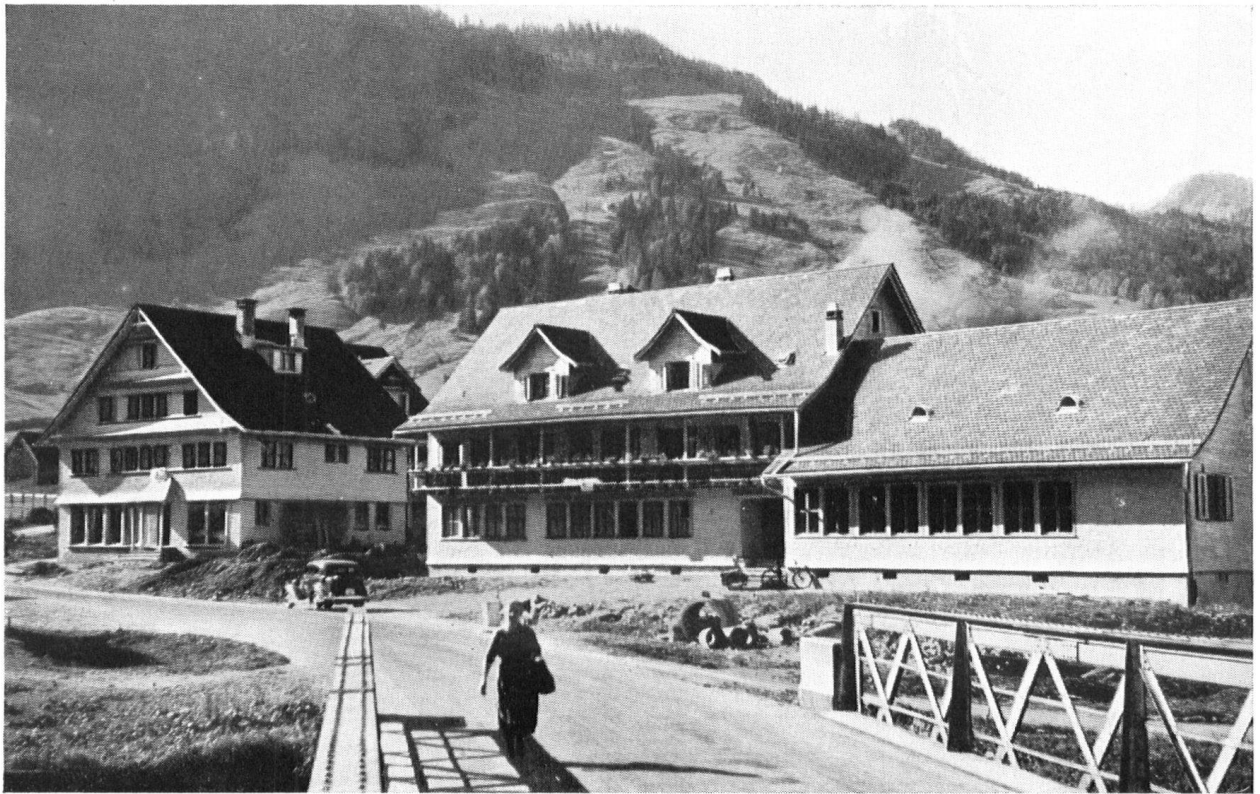
Stein im Toggenburg. Wiederaufbau des durch ein Brandunglück vernichteten Dorfkernes nach den Plänen unserer Bauberatungsstelle (Arch. Max Köpp). Stein, dans le Toggenbourg, dévasté par un incendie, se reconstruit d'après les plans de notre service technique (architecte: M. Max Köpp). Stein nel Toggenburg. Ricostruzione del centro del villaggio distrutto da un incendio. Progetto del nostro Ufficio di consulenza edile (Arch. Max Köpp).
