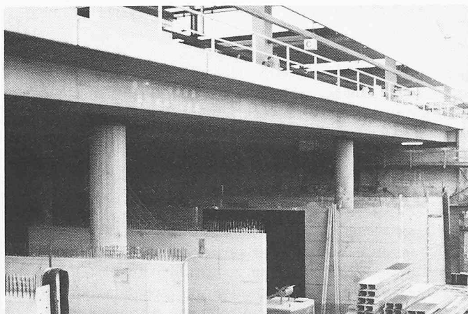
Bild 5. Bereits fertig erstellte Brücken unter den bestehenden Bahngleisen zur Einführung der S-Bahnen, darüber die neue Bahnhofshalle
