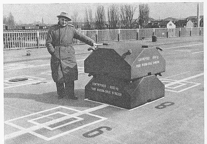
Bild 52. Einzellast von 12 t
