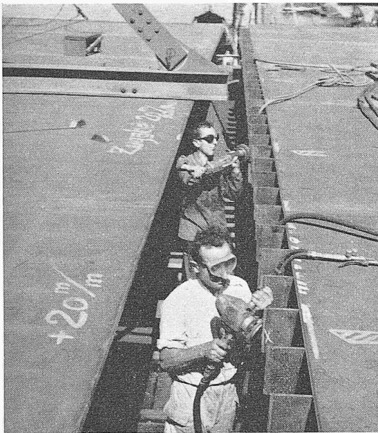
Bild 25. Bearbeiten eines Passtosses zum Ausgleich der Schrumpfung der Schweißung der Montagestumpfstösse der orthotropen Platte. Solche Passtösse wurden alle drei bis vier Platten angeordnet. Montagefortgang von rechts nach links. Beim Plattenstück links ist ein Teil der Aufhängevorrichtung zum Versetzen sichtbar
