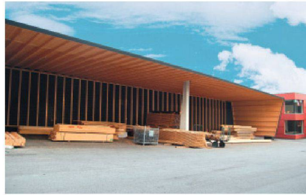
02 «Hauer Holztechnik Halle»: Bescheidene Überdachung mit verstecktem Tragwerk (Foto: holzheu/ecoplus)
