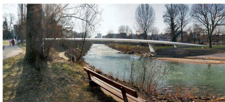
09 Zwei Stahlhohlkastenträger mit variablen Querschnitten und tragender Stahlplatte
