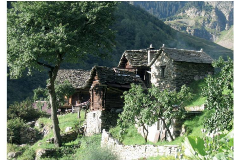
01 Rustici am Dorfrand von Madra im Val Malvaglia. Der Umbau von Rustici im Tessin erhält endlich eine gesetzliche Basis (Foto: rw / Red.)
