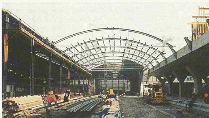
Bild 3. Schutz- und Arbeitsbühne über den Gleisen
