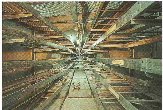
Bild 2. Blick in den Kabelstollen (Montagezustand)
