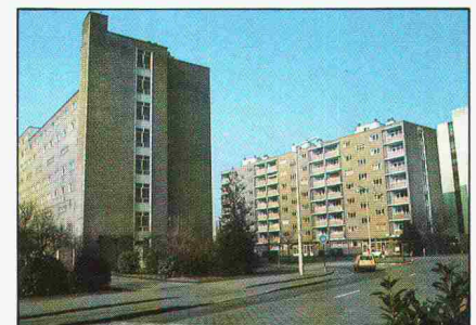
▲ Belgien: Sozialer Wohnungsbau, Gent. (Sanierung)
