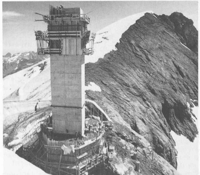
Bild 13. Rohbau August 1982: Liftturm mit Kletterschalung. Rechts im Hintergrund der Titlis
