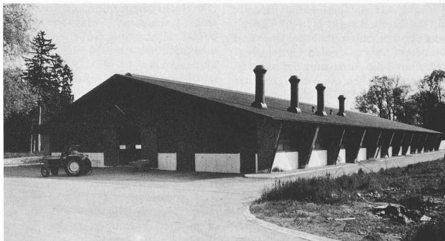
Bild 1. Strafanstalt Witzwil. Kuhstall des Gutsbetriebes
